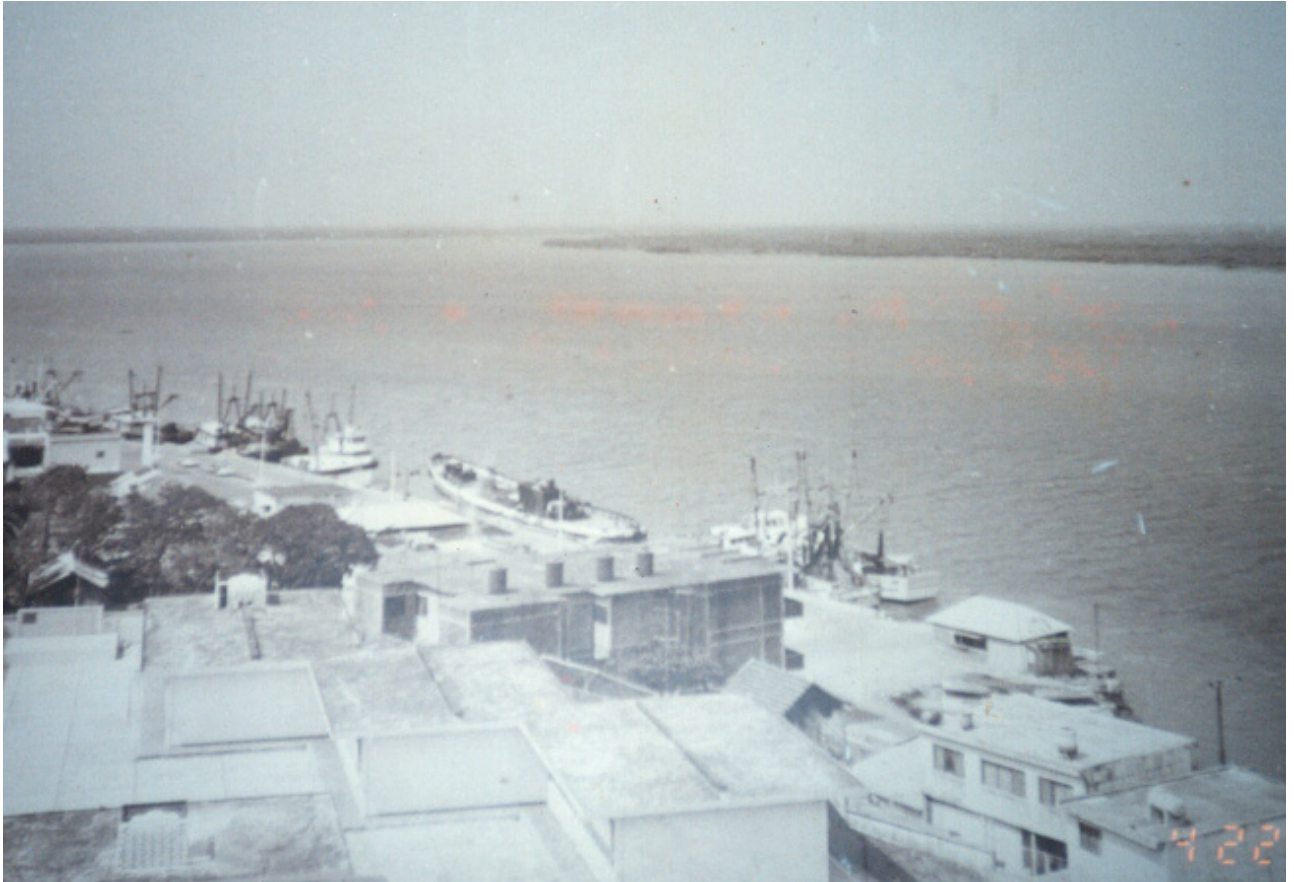
Vista desde la cercanía del muelle fiscal ubicado sobre la orilla izquierda del río de Coatzacoalcos.
