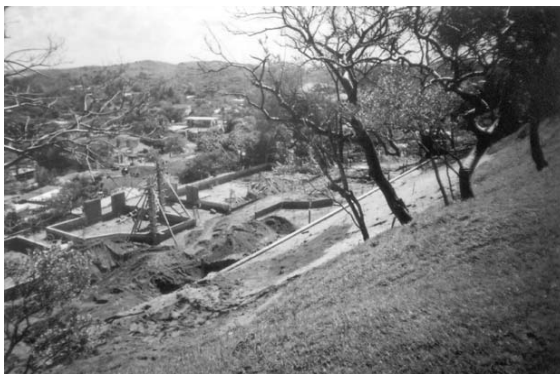
Inicio de construcción atrás del museo
