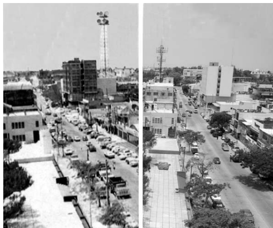
El hotel (Izq.) en construcción; y (Der.) como luce hoy
