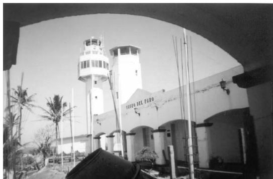
Construcción de la cafetería
