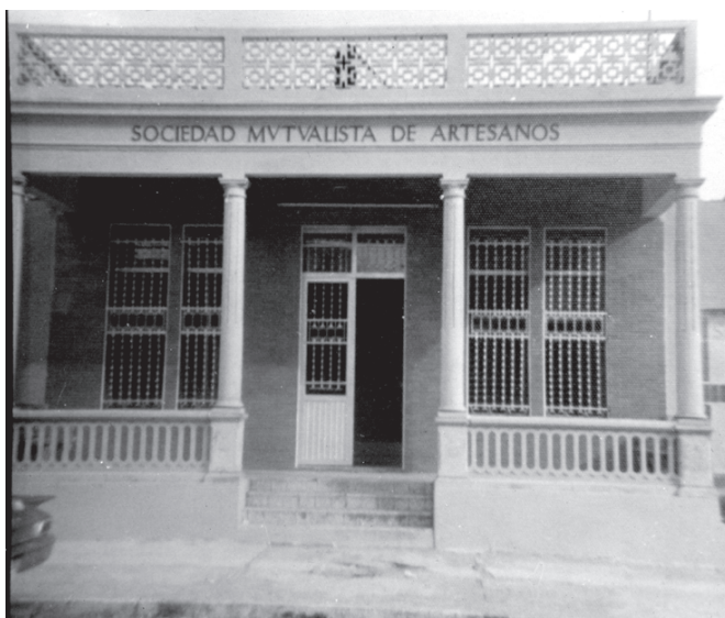
El añejo edificio
