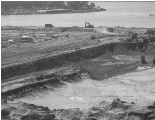
Excavación del Dique Seco
