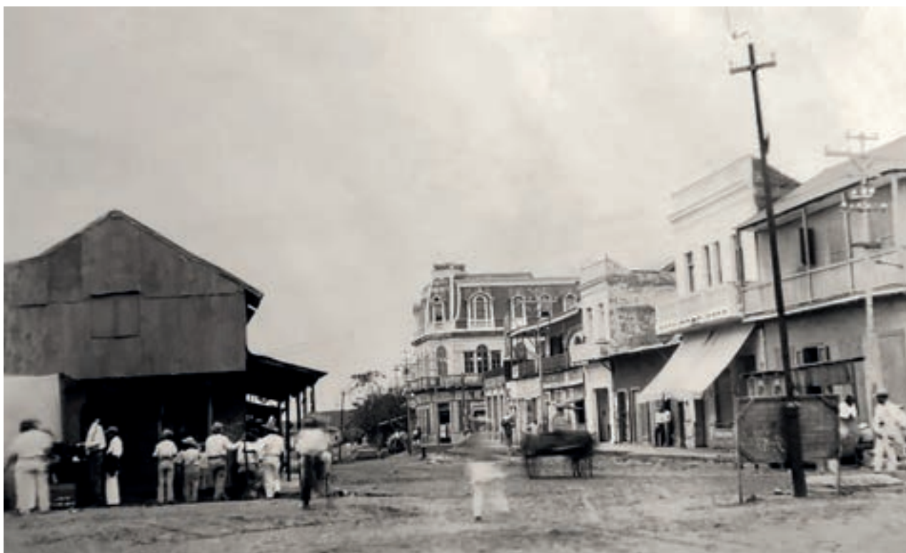
AVENIDA CORREGIDORA, Puerto México.
