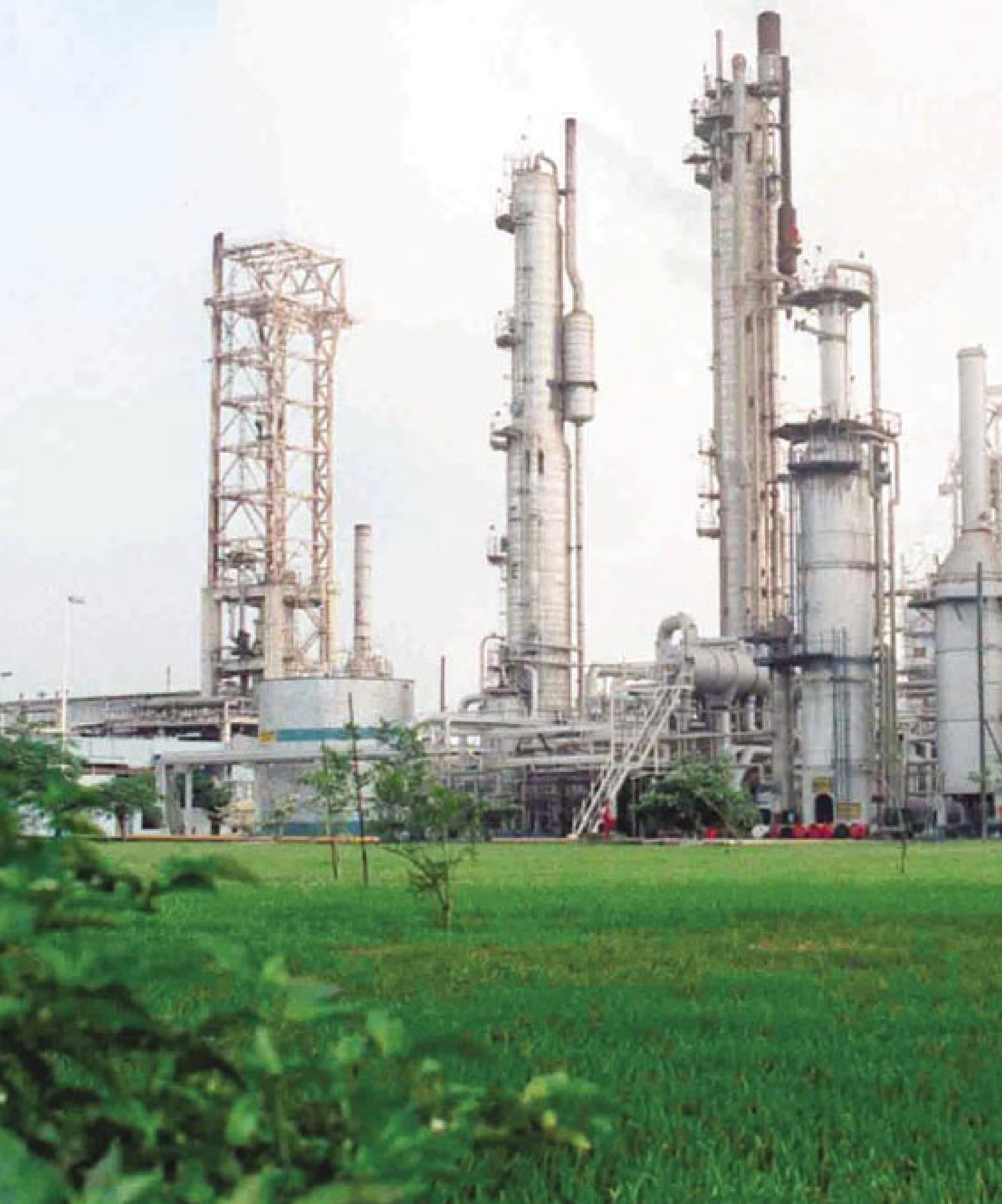
COMPLEJO COSOLEACAQUE , planta de amoníaco y torre de enfriamiento.
