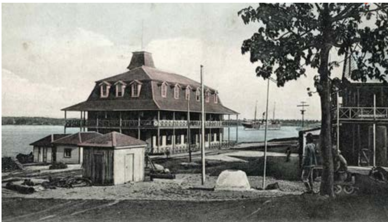
OFICINA DE OBRAS PORTUARIAS, conocida como la pagaduría.
