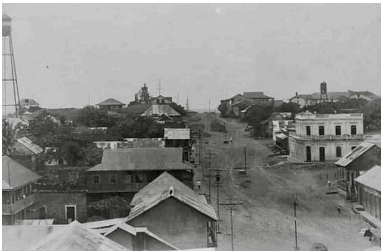
AVENIDA CORREGIDORA, Puerto México.
