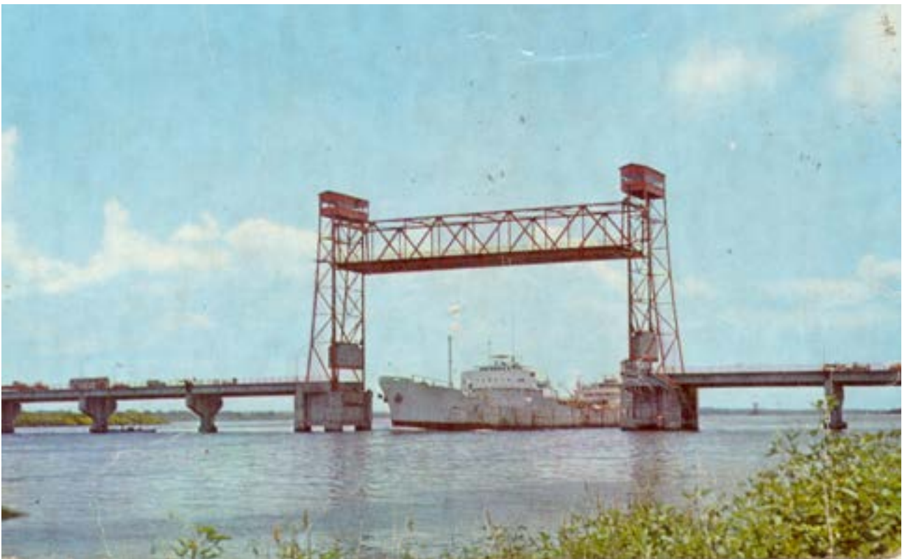
PUENTE ELEVADO Coatzacoalcos I.
