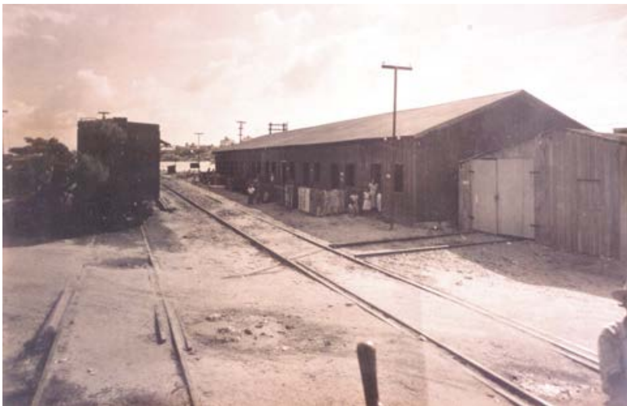
Otra estación existente en la Terminal de Allende del Ferrocarril del Sureste, próxima a la orilla derecha de río y siendo enfrente de Coatzacoalcos.
