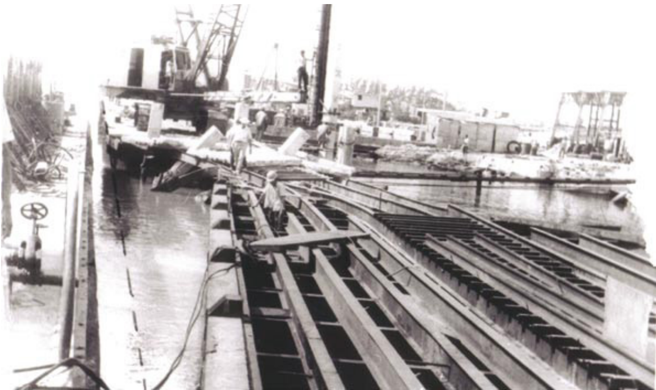
Obras del puerto en Coatzacoalcos, construyéndose a inicios del siglo XX con el tendido de traves metalicas para los muelles.
