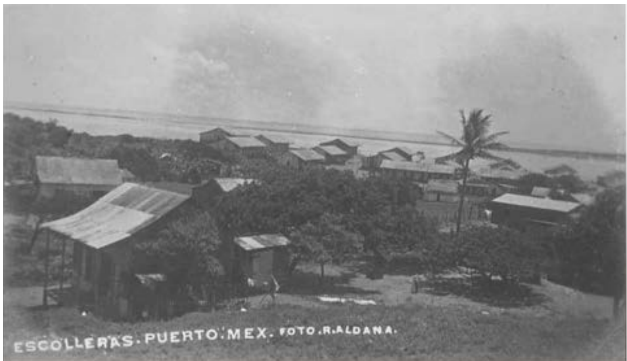
VISTA DE COATZACOALCOS, con las escolleras al fondo.
