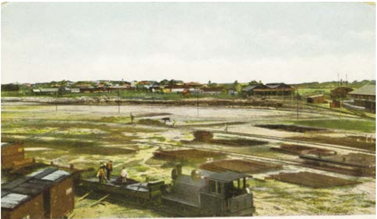
Se ha estimado fuese toda el área del patio previsto para la terminal en Coatzacoalcos de la estación de pasajeros y carga del Ferrocarril de Tehuantepec, en etapa de acondicionamiento.
