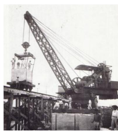
LAS ESCOLLERAs fueron construidas con un núcleo de bloques de concreto, rodeado y protegido por rocas de 5 toneladas. El Mundo Ilustrado
