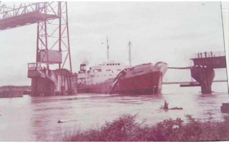
**EN 1972, LA FUERTE CORRIENTE** a la altura del puente Coatzacoalcos hizo derivar al buque tanque Lázaro Cárdenas dando por resultado el derrumbe de un tramo del puente, junto con la vía férrea. El tráfico hacia el sureste se vio suspendido.
