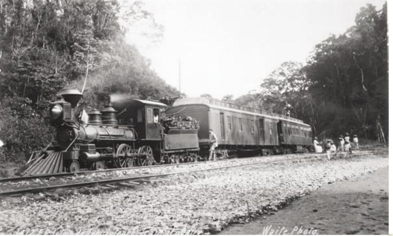
EL "PERSONAJE" central de la historia de la región, el Ferrocarril Nacional de Tehuantepec, tren pasajero con locomotora de configuración de ruedas 4–4–0, 4 guías, 4 de propulsión y 0 de salida.
