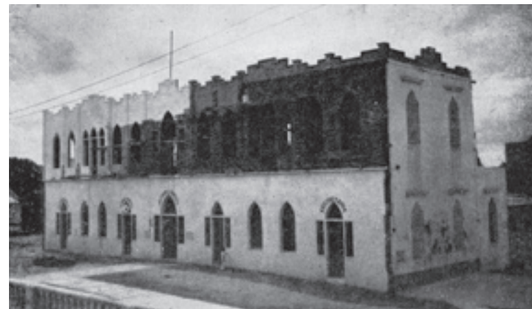
Palacio Municipal proyectado por Gobierno del Estado, y construido por varios ayuntamientos.
