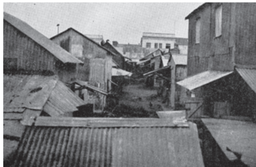
Dos vistas del mercado municipal.
