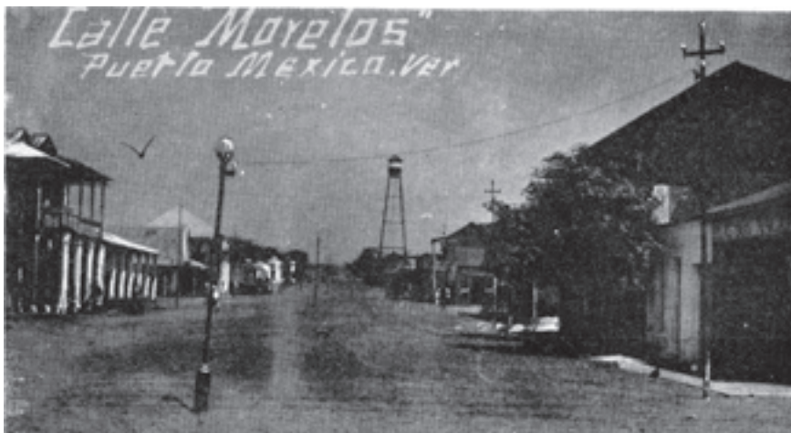
Primera calle Morelos. Al fondo el tanque elevado de la Cía. Mex. De Pet. "El Águila".
