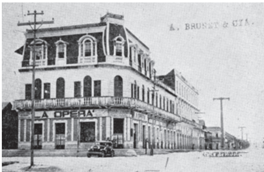
Edificio Brunet: planta baja, cantina “La Opera”, en la siguiente el Casino Puerto México y en la última el hotel Brunet. A media cuadra el hotel Tubilla y al final el hotel Carta Blanca.
